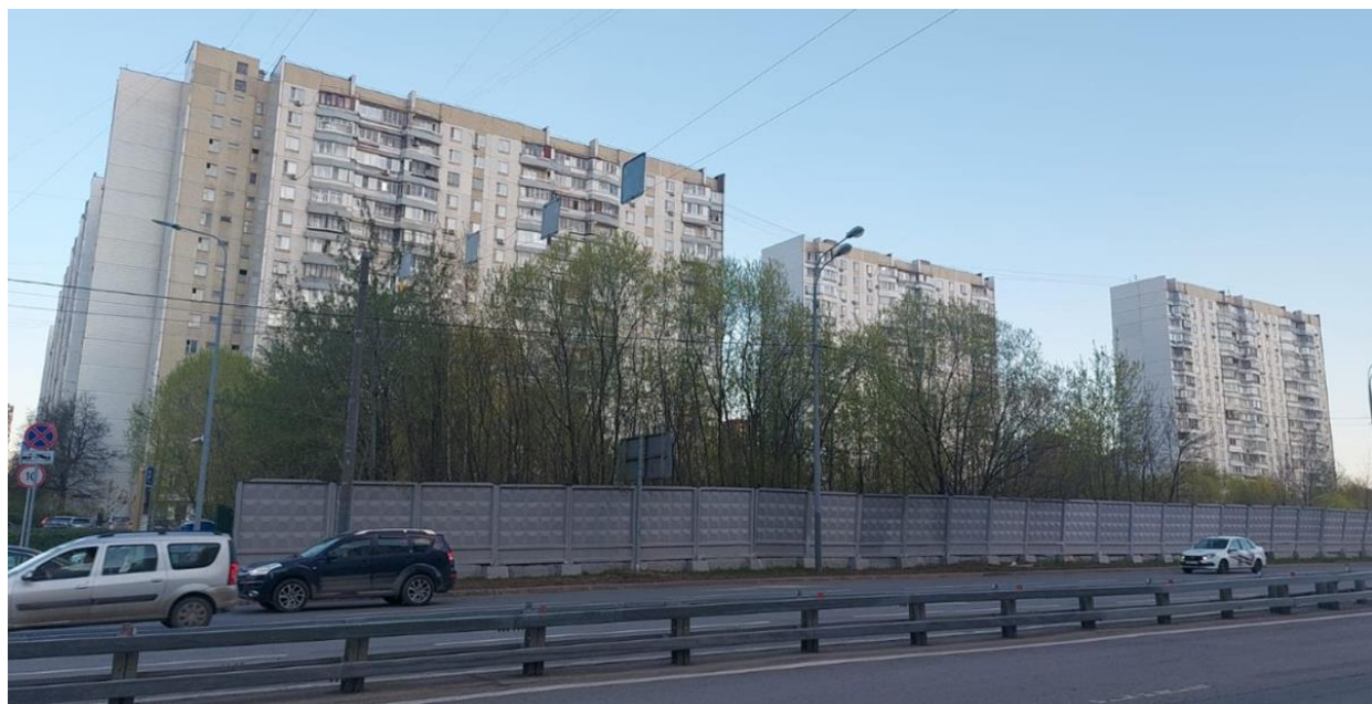
Замена ограждения Б-р Дмитрия Донского (долгострой)
